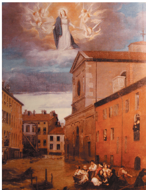
Lors de l'inondation de la Guillotière, le 31 mai 1856, la rue de la Madeleine dévastée et l'église Notre-Dame Saint-Louis paroisse sur laquelle se trouvait la salle du Prado. Ex-voto de Jean Scohy conservé à la paroisse Notre-Dame Saint-Louis.
